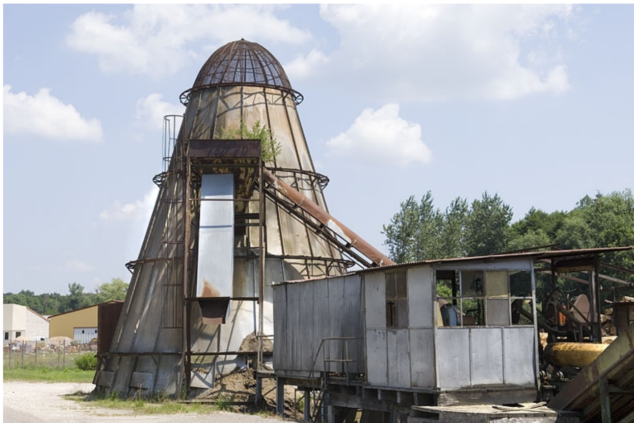
Poste d'écorçage et four à écorces.
