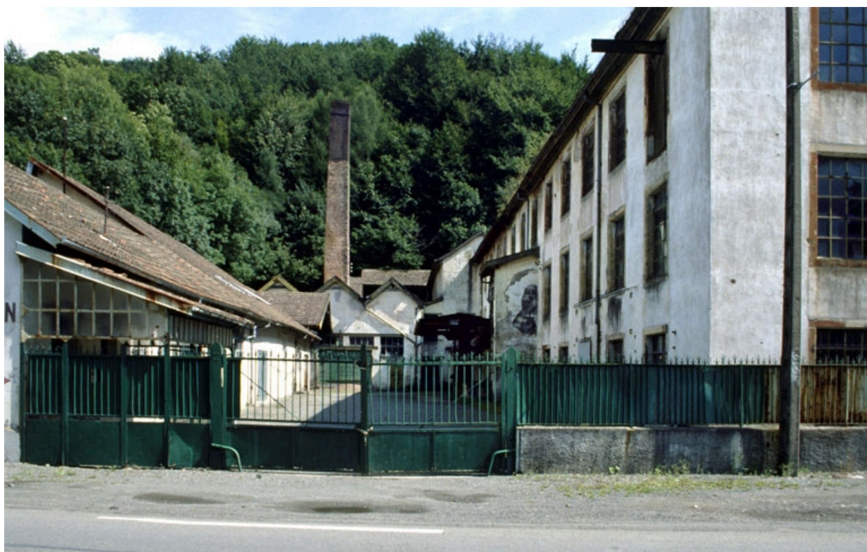
La cour de l'usine.
