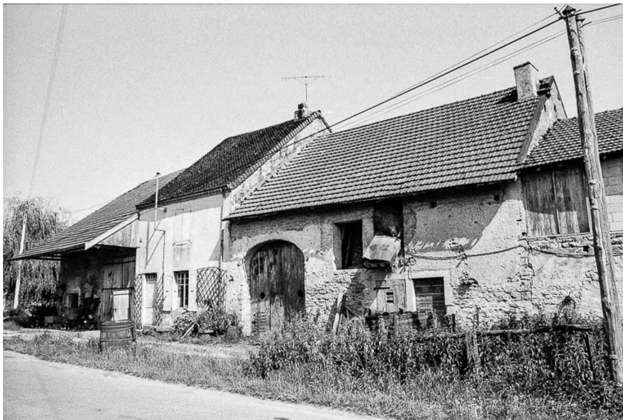
Maison cadastrée 1960 AI 8 : façade antérieure.
