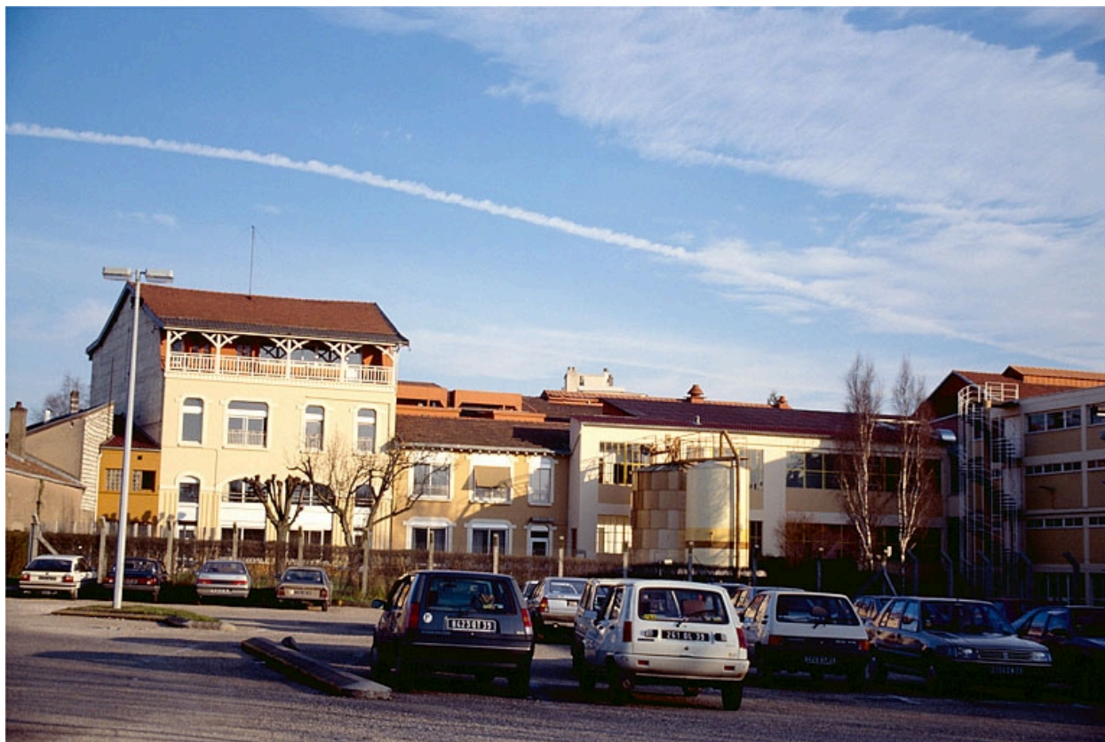
Bureau et atelier de fabrication (E).
