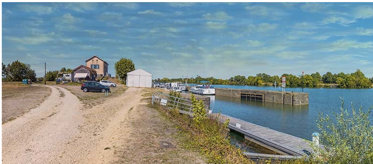
L'ancienne écluse depuis l'aval : l'entrée du port de plaisance.
