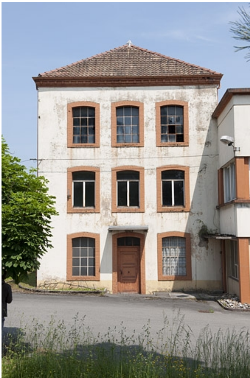
Bâtiment d'entrée. Façade sud-ouest.
