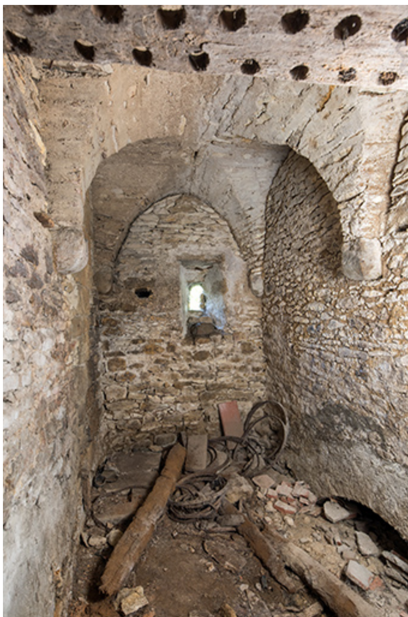
Le premier niveau du colombier, en direction de la Cure.
