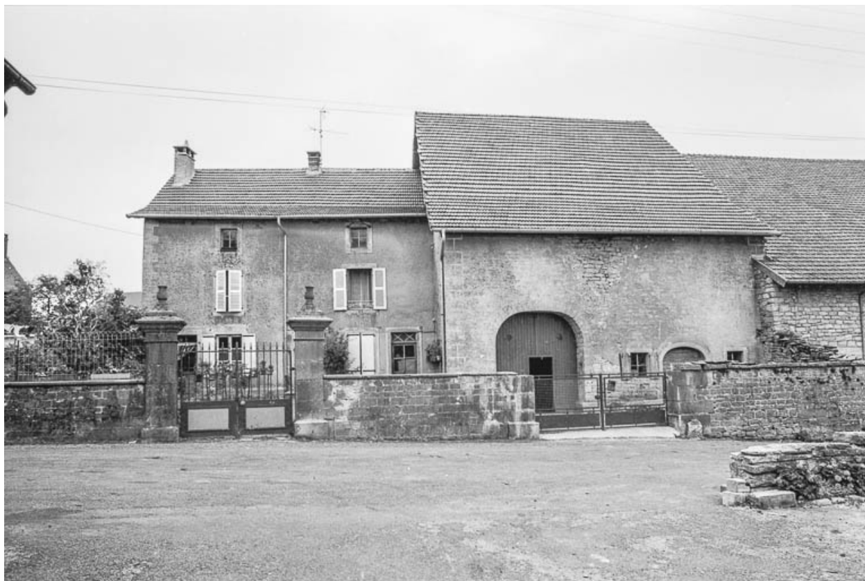
Ferme cadastrée 1951 E1 130 : façade antérieure.
