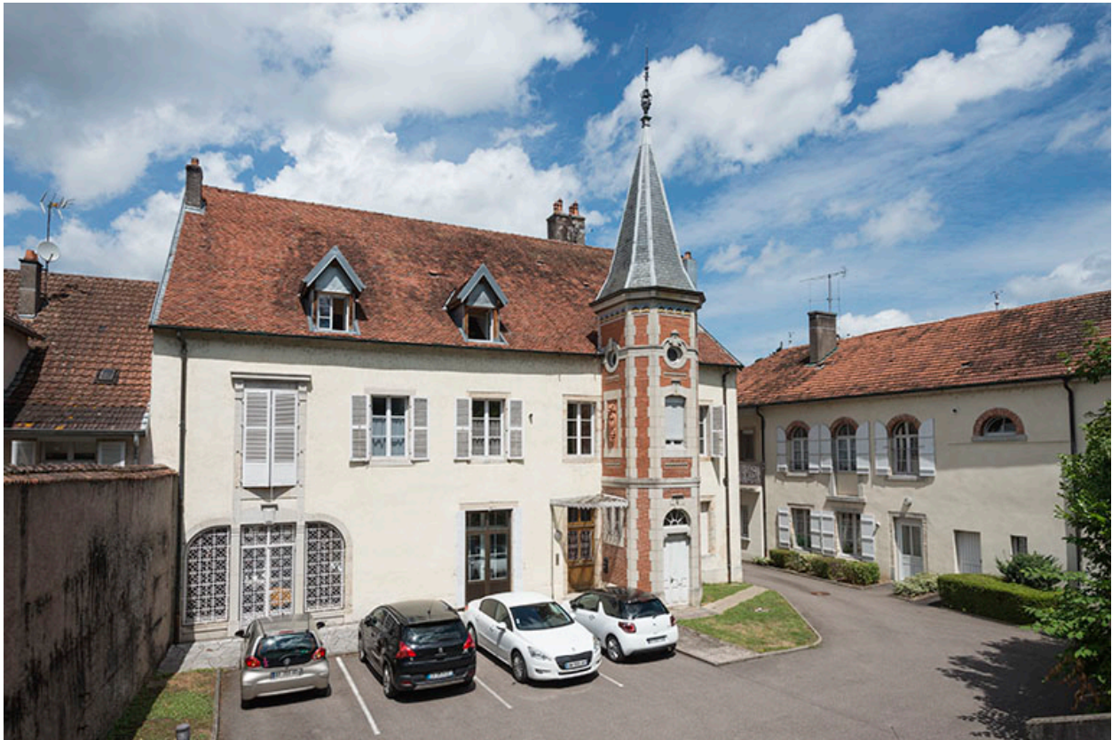
Façade postérieure de la demeure.
