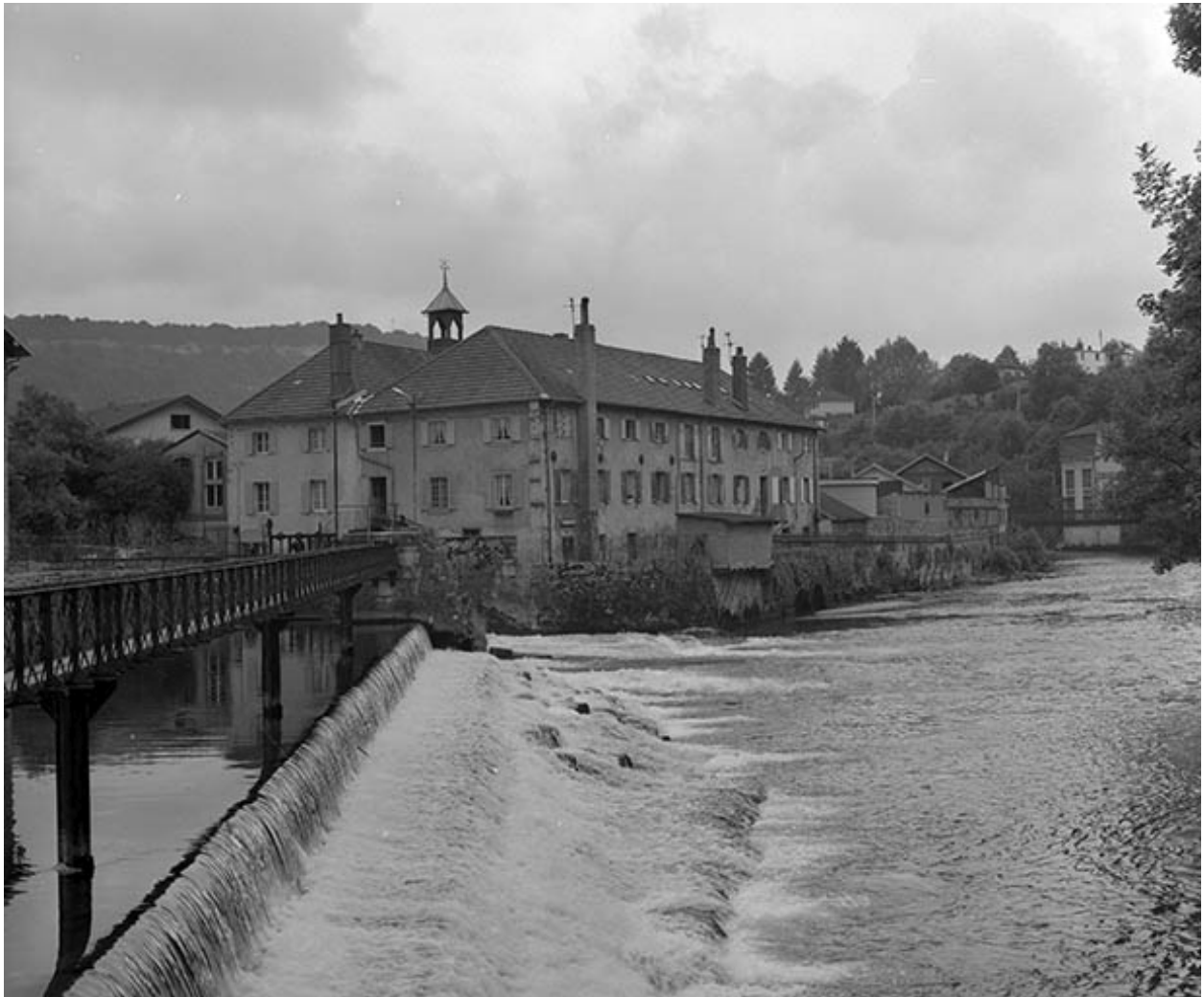
Atelier de fabrication depuis la rive droite du barrage en 1981.
