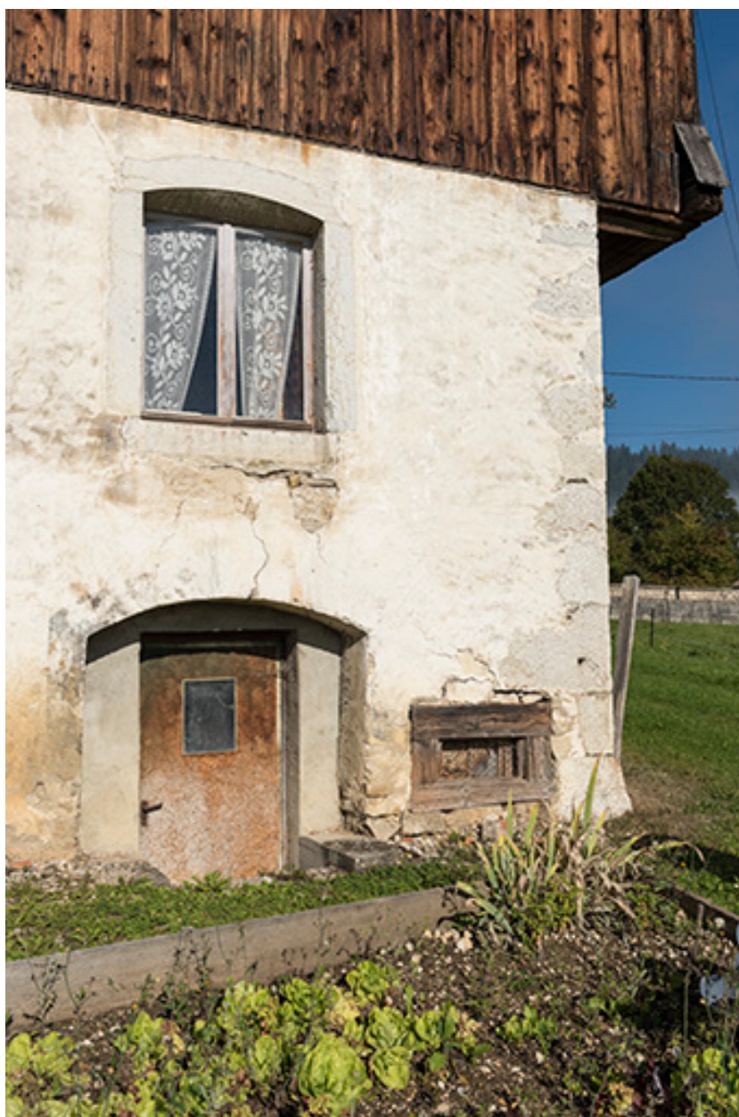
Façade est : accès au sous-sol (extension nord-est).
