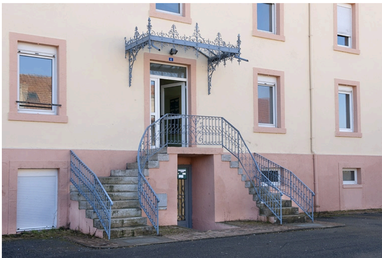
Façade antérieure. Entrée principale.
