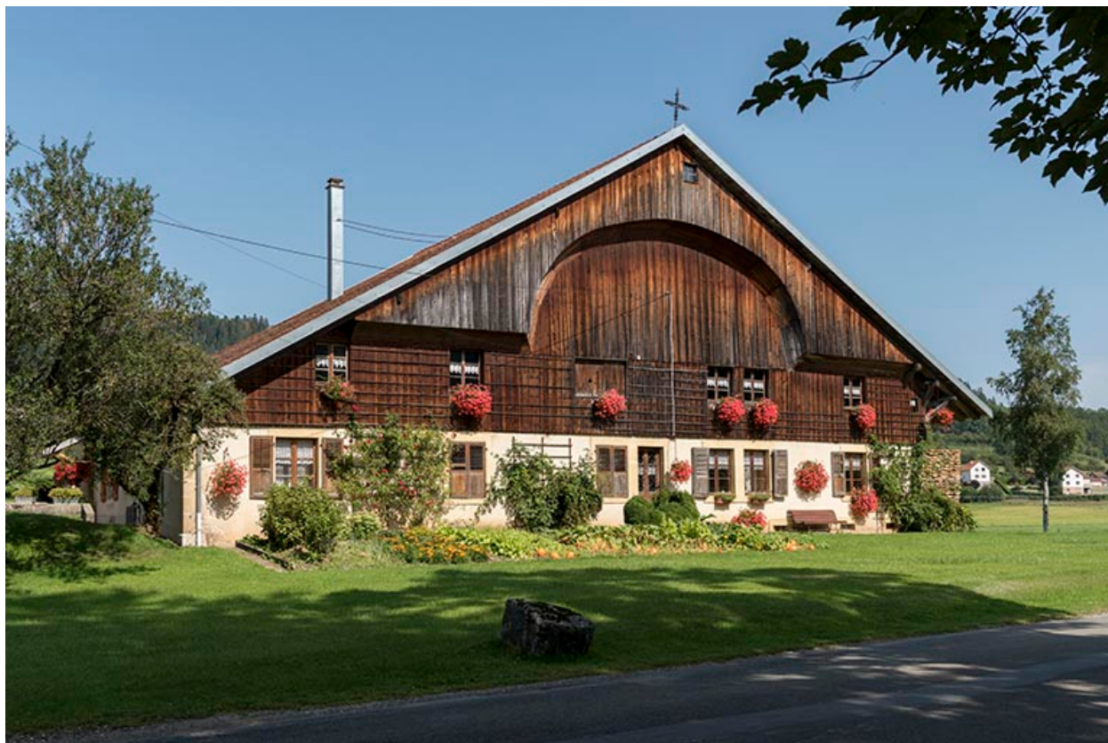
Ferme : façade antérieure, de trois quarts gauche.
