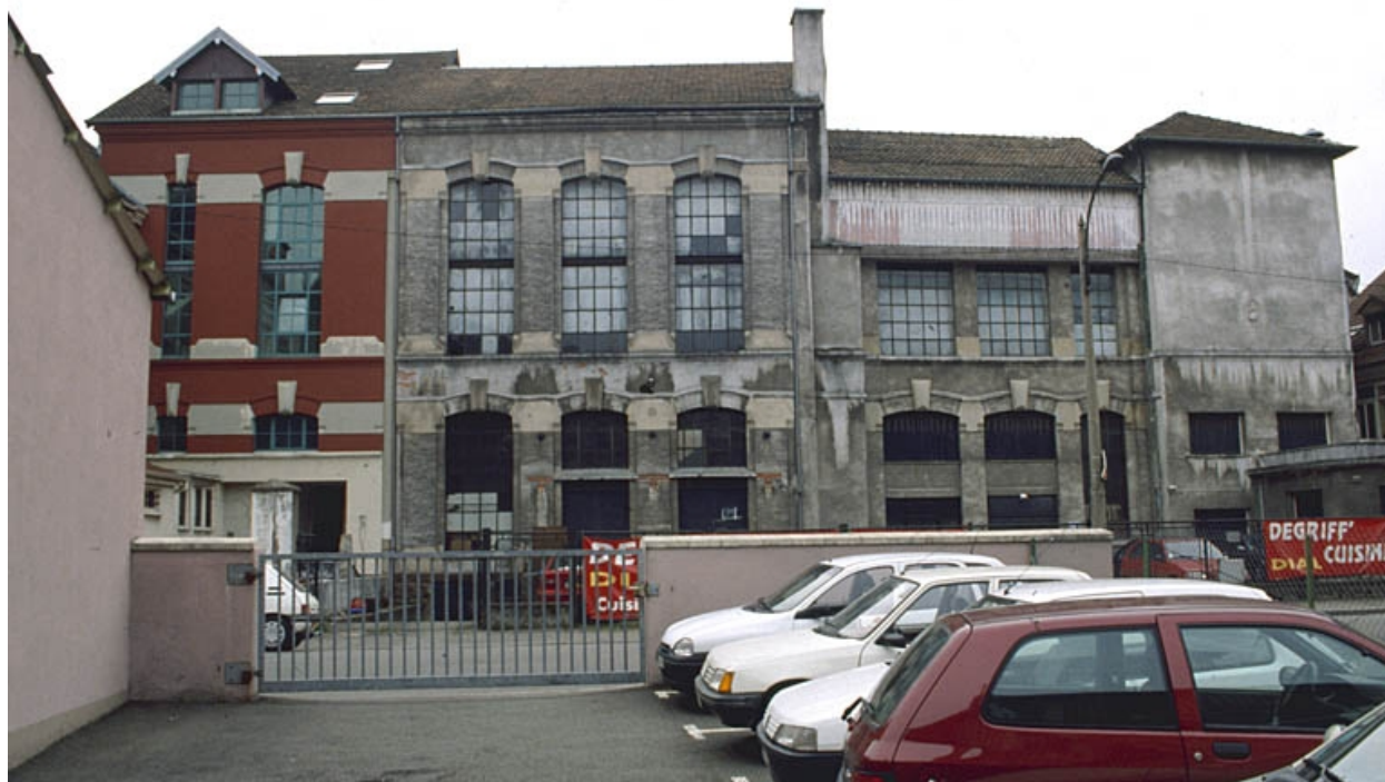
Façade antérieure de l'atelier de fabrication.
