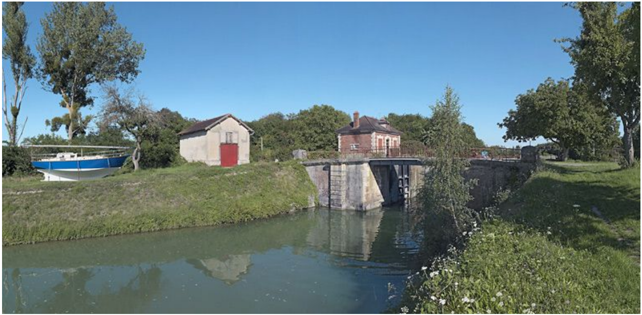
Vue d'ensemble prise d'aval.
