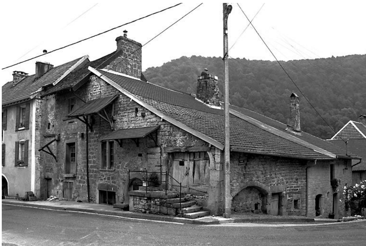
Façade antérieure et façade latérale droite.
