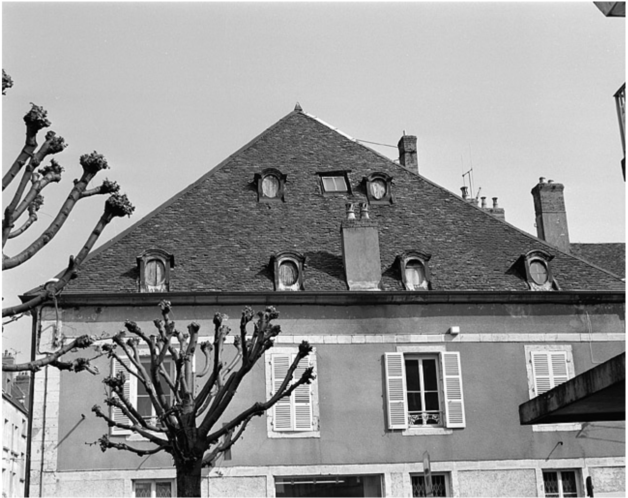
Toiture et façade latérale droite de la maison donnant rue Gambetta.
