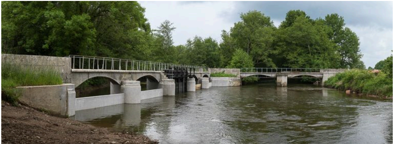
Corbigny, barrage de prise d'eau sur l'Yonne.
