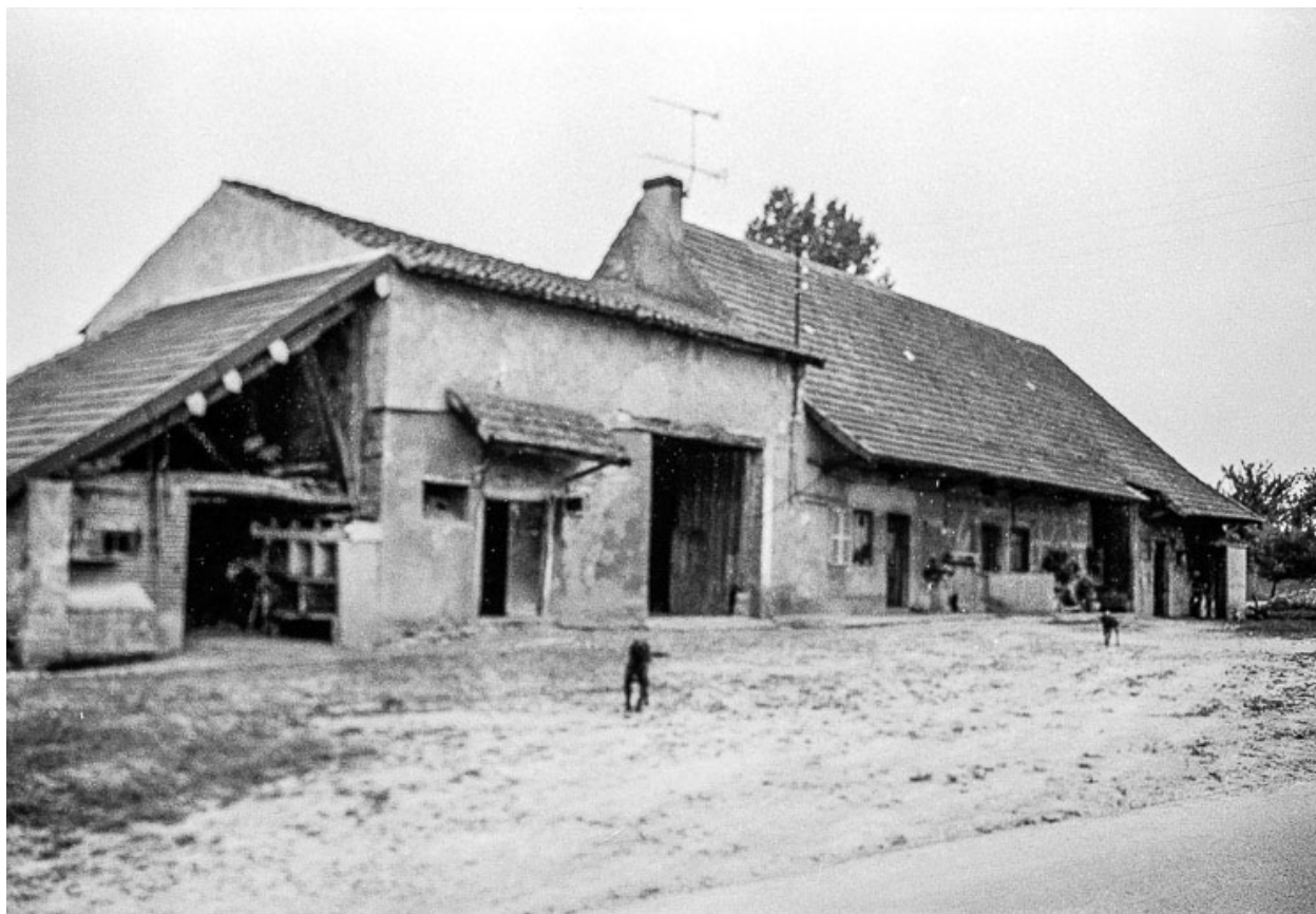
Ferme cadastrée 1969 AM 8 : façade antérieure.
