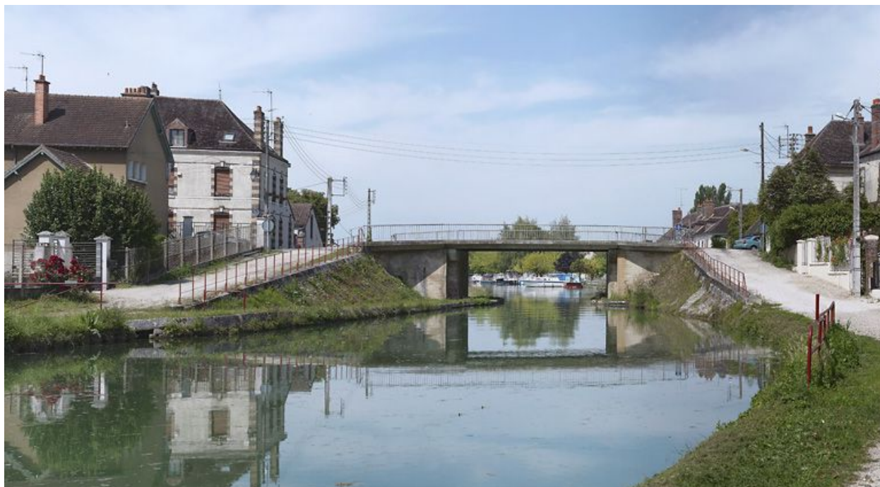
Vue d'ensemble prise d'aval.
