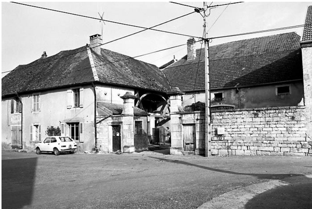
Ferme située 3 Grande Rue à Vantoux.
