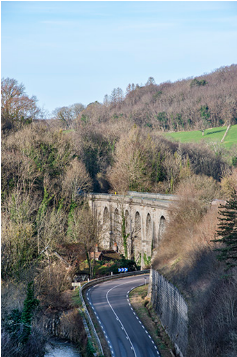
Vue rapprochée du viaduc, depuis l'est.
