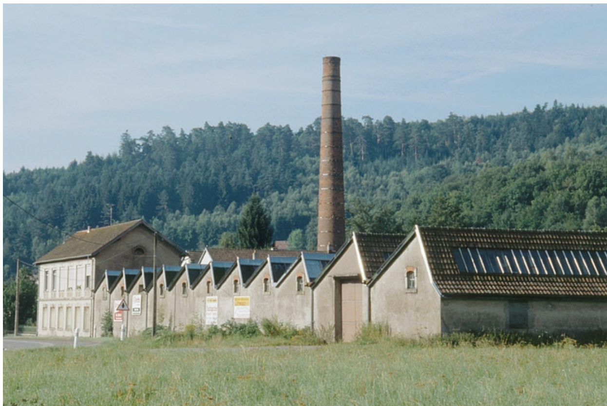
Façade sur la route départementale 465.
