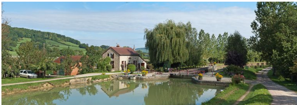
Vue du site d'écluse depuis l'amont.
