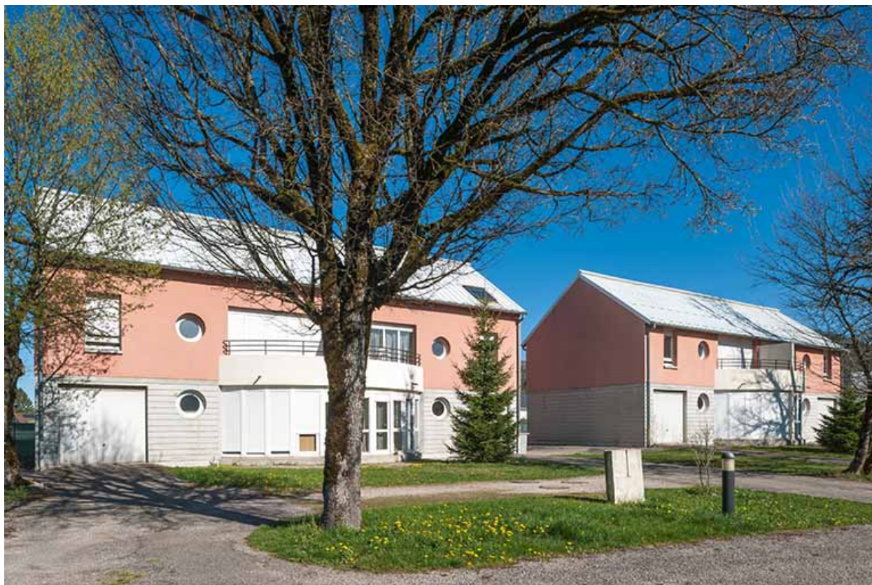
Logements : façades antérieures.
