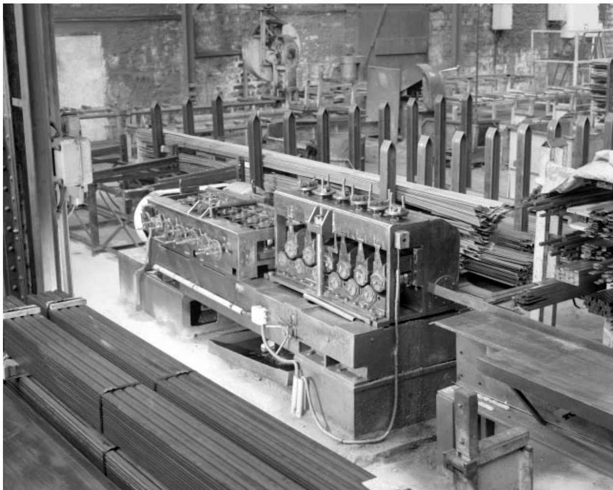
Machine à redresser de l'Office Technique des Profilés.
