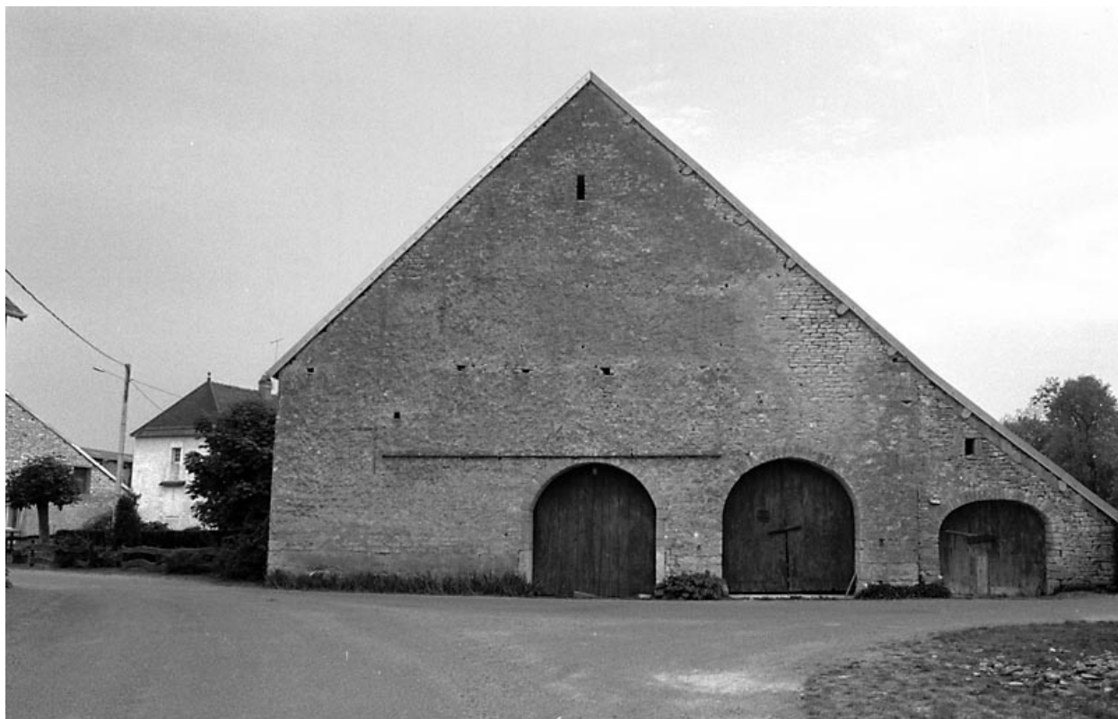
Façade latérale droite.
