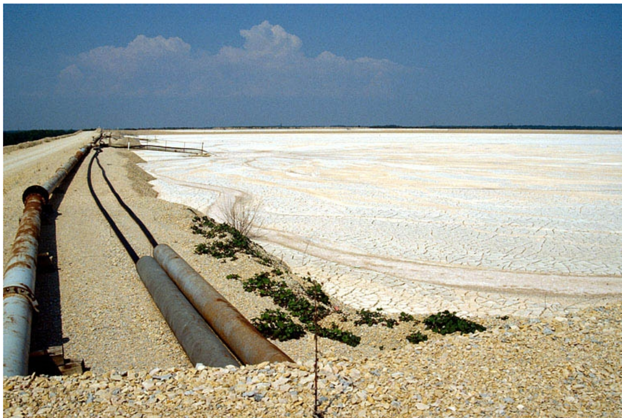
Bassins de décantation.
