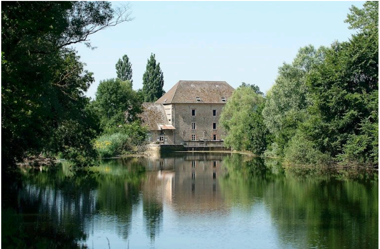
Moulin de Loisy, vu d'amont.
