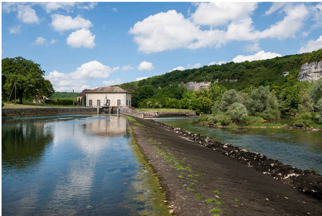
Le barrage de la centrale hydroélectrique.
