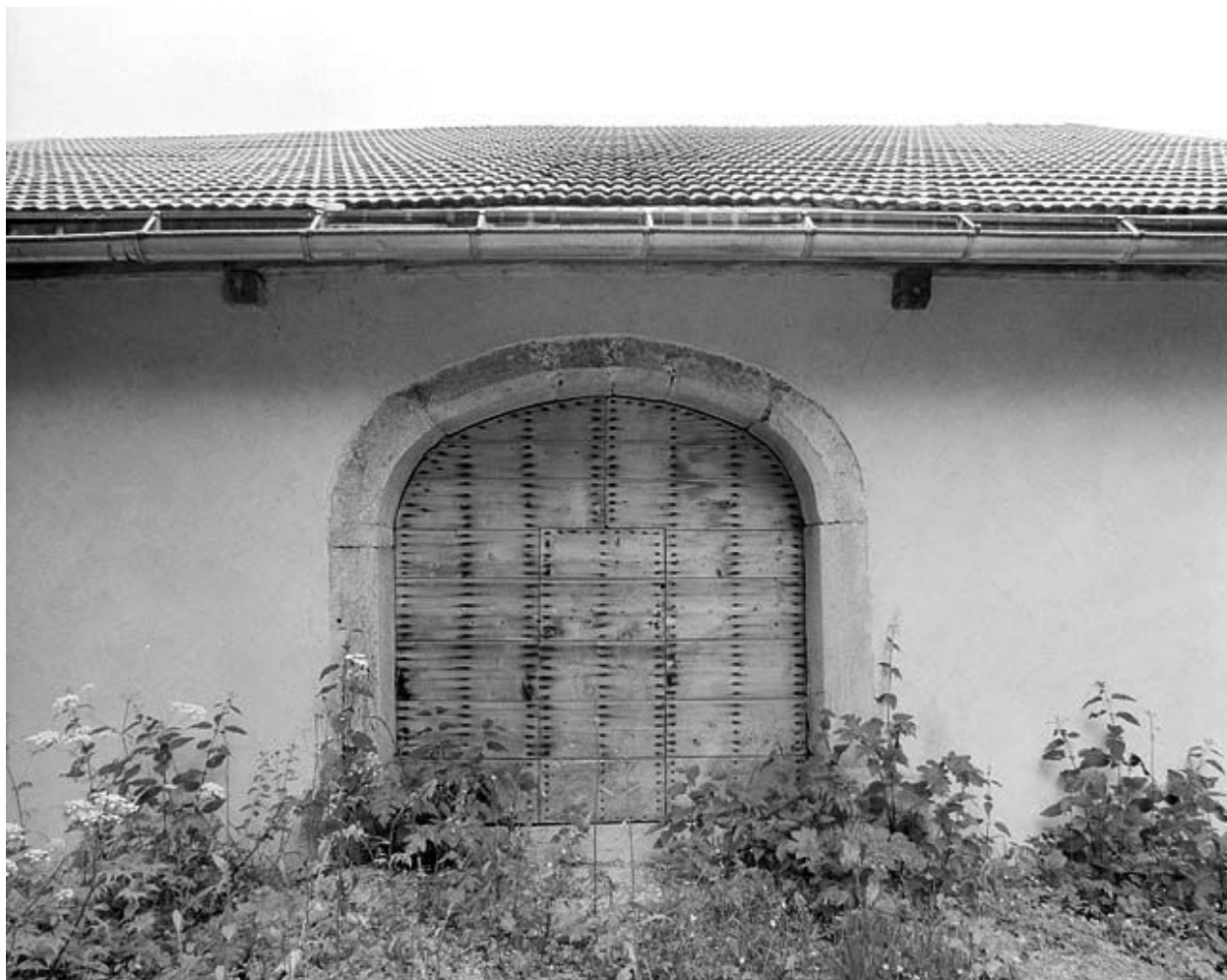
Porte de grange sur la façade postérieure.
