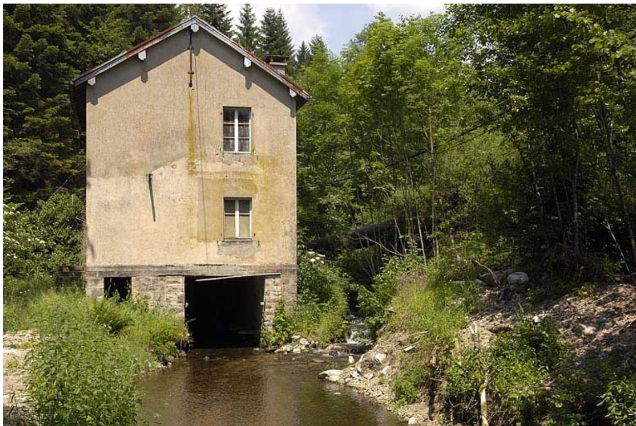
Vue depuis l'aval.
