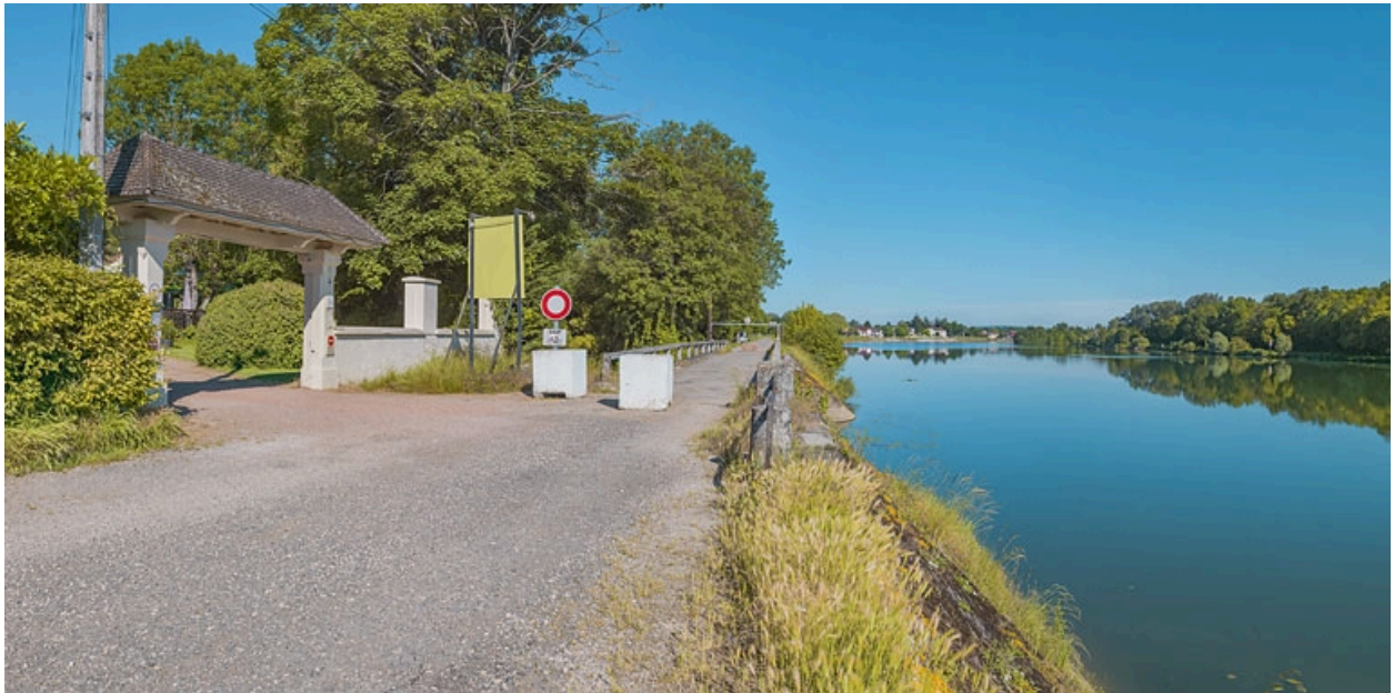
Extrémité aval du quai avec le pont sur la Roie de Droux.
