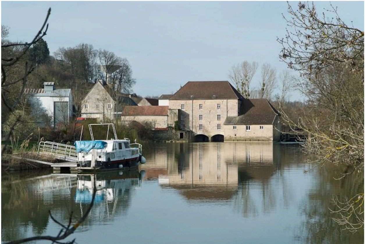
Moulin de Loisy, vu d'aval. Un appontement moderne à gauche au premier plan.
