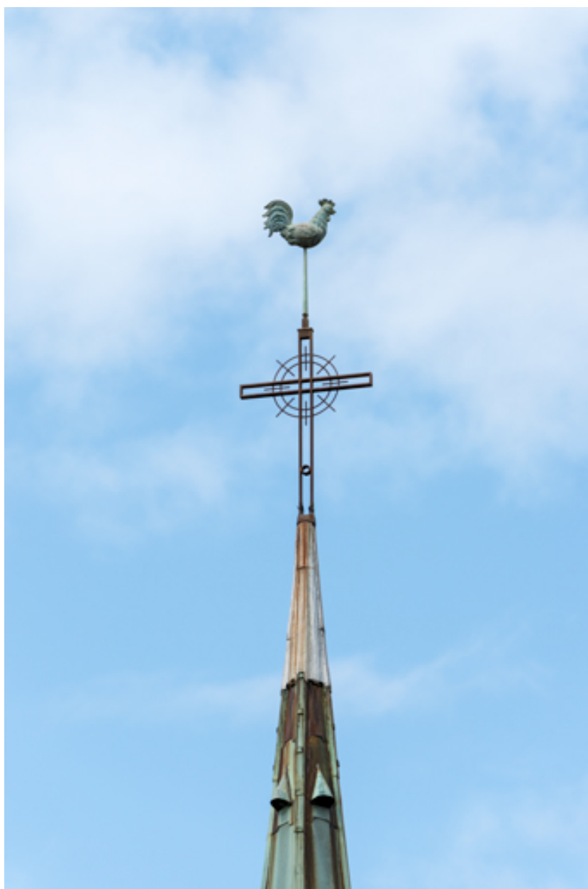
Flèche, détail de la croix et du coq.
