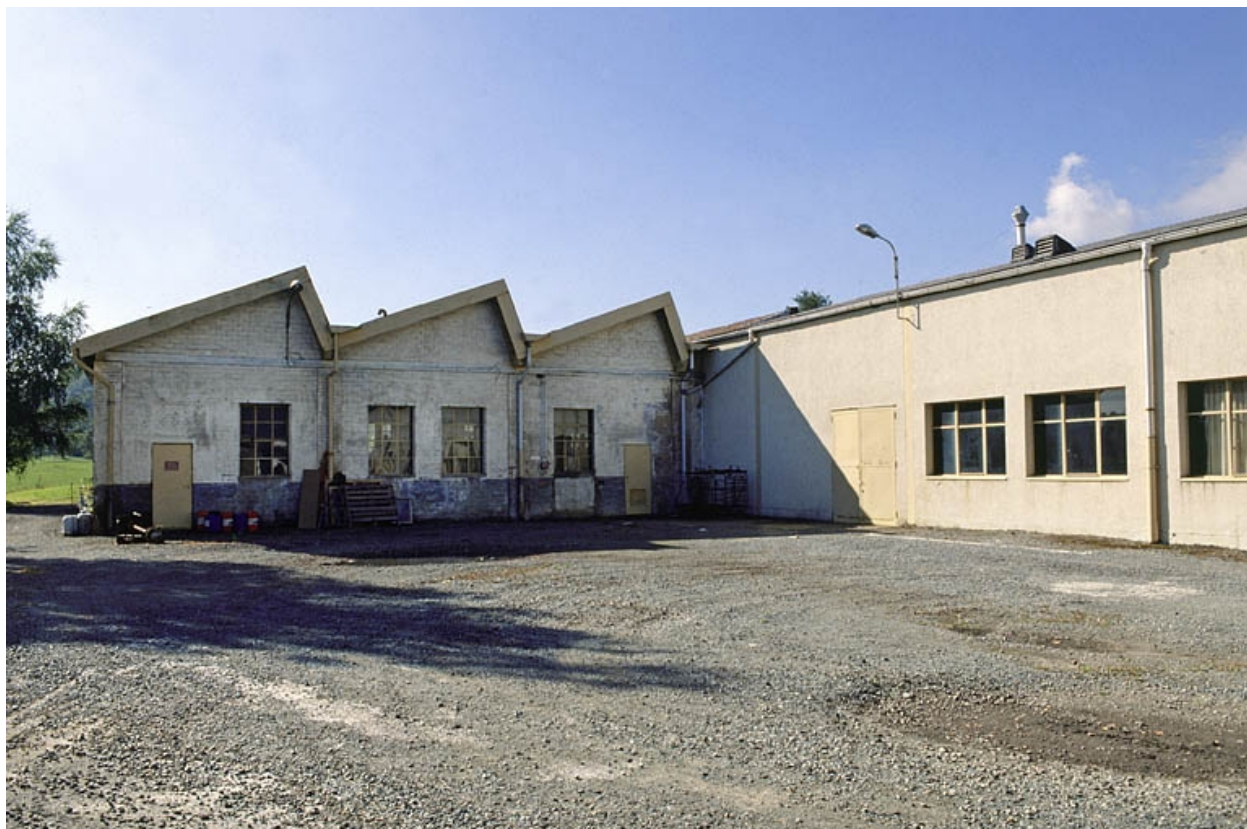
Ateliers de fabrication ouest.
