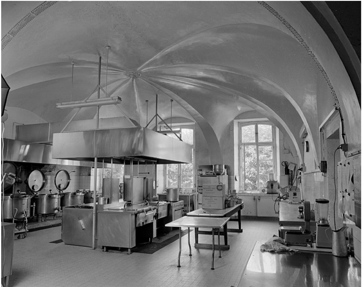
Cuisines : vue d'ensemble.
