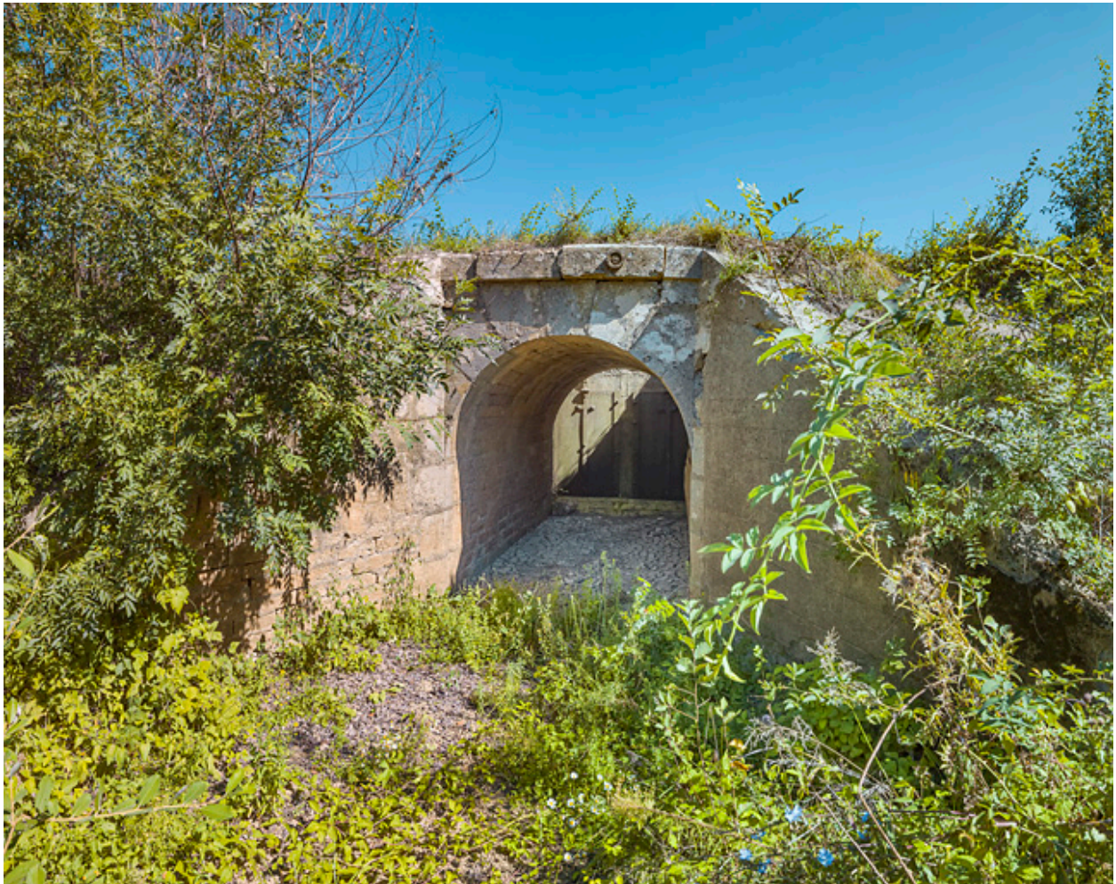
Vue d'ensemble du ponceau et des vannes, rive gauche.
