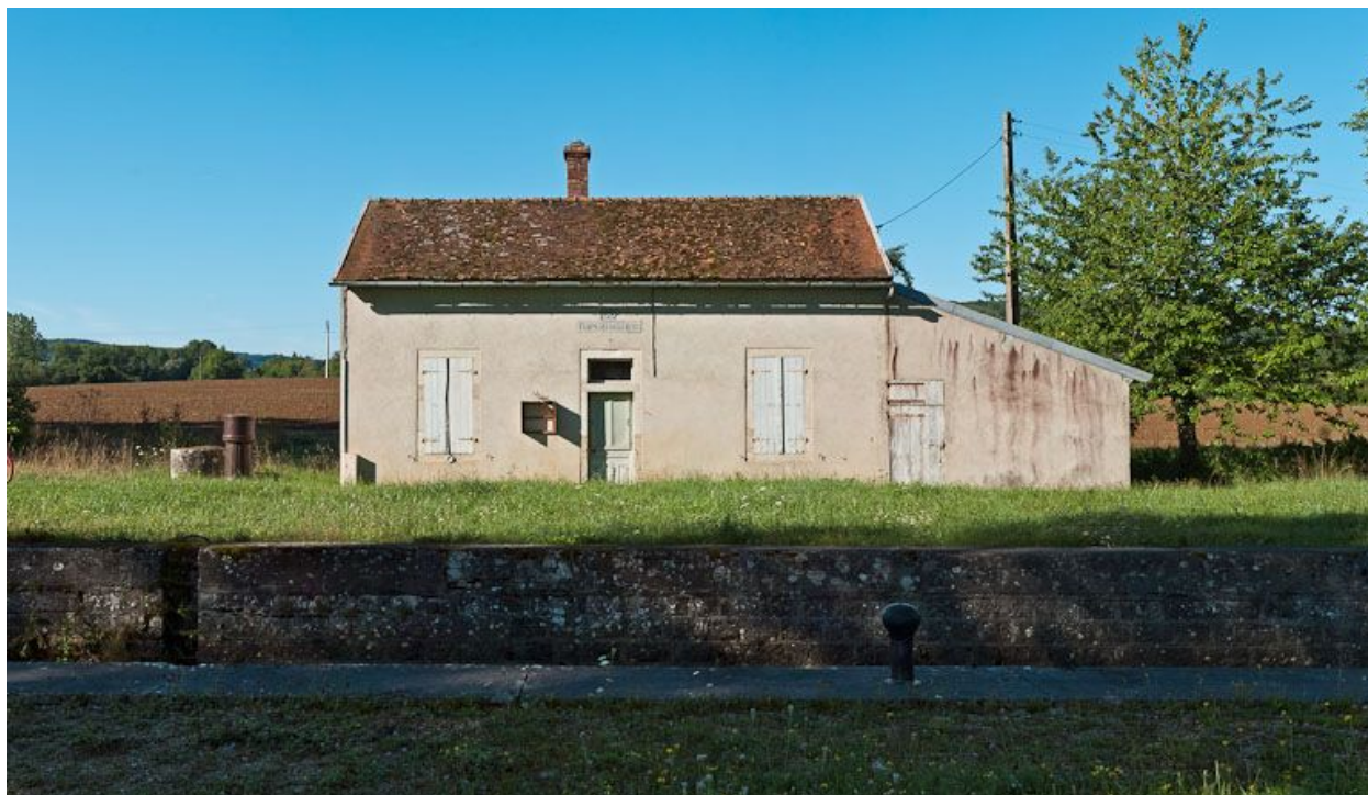
Vue de face de la maison éclusière.
