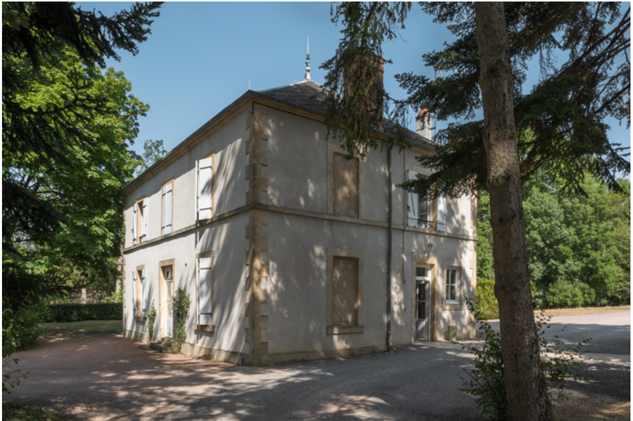
Vue de la villa depuis le sud-est.
