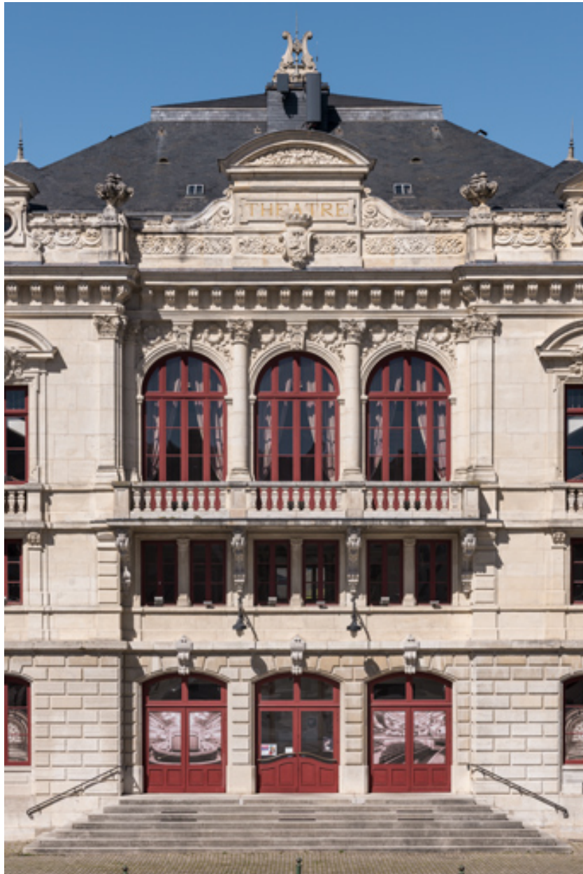
Façade antérieure : travée centrale.
