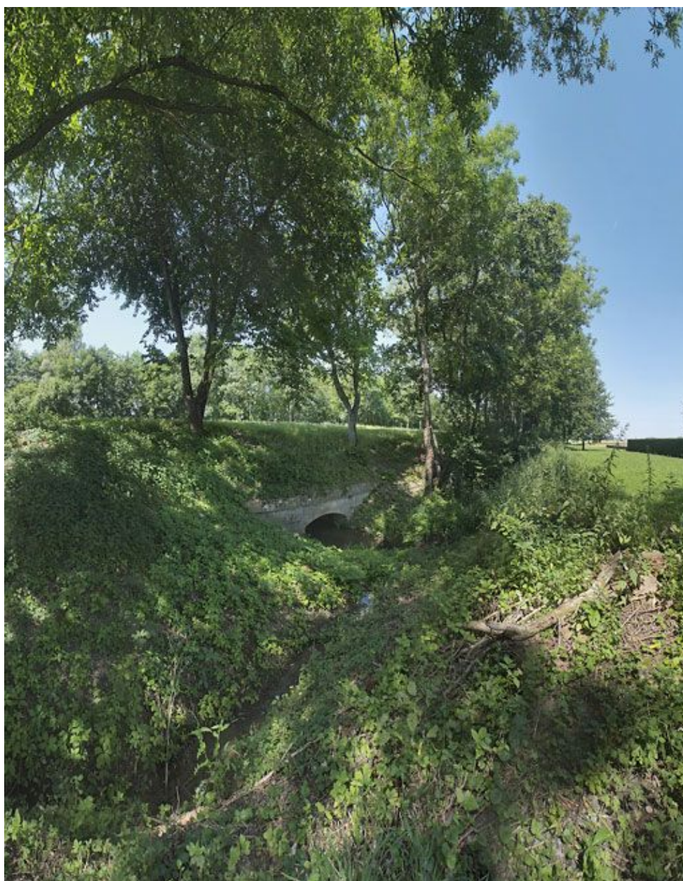
Vue de l'aqueduc.
