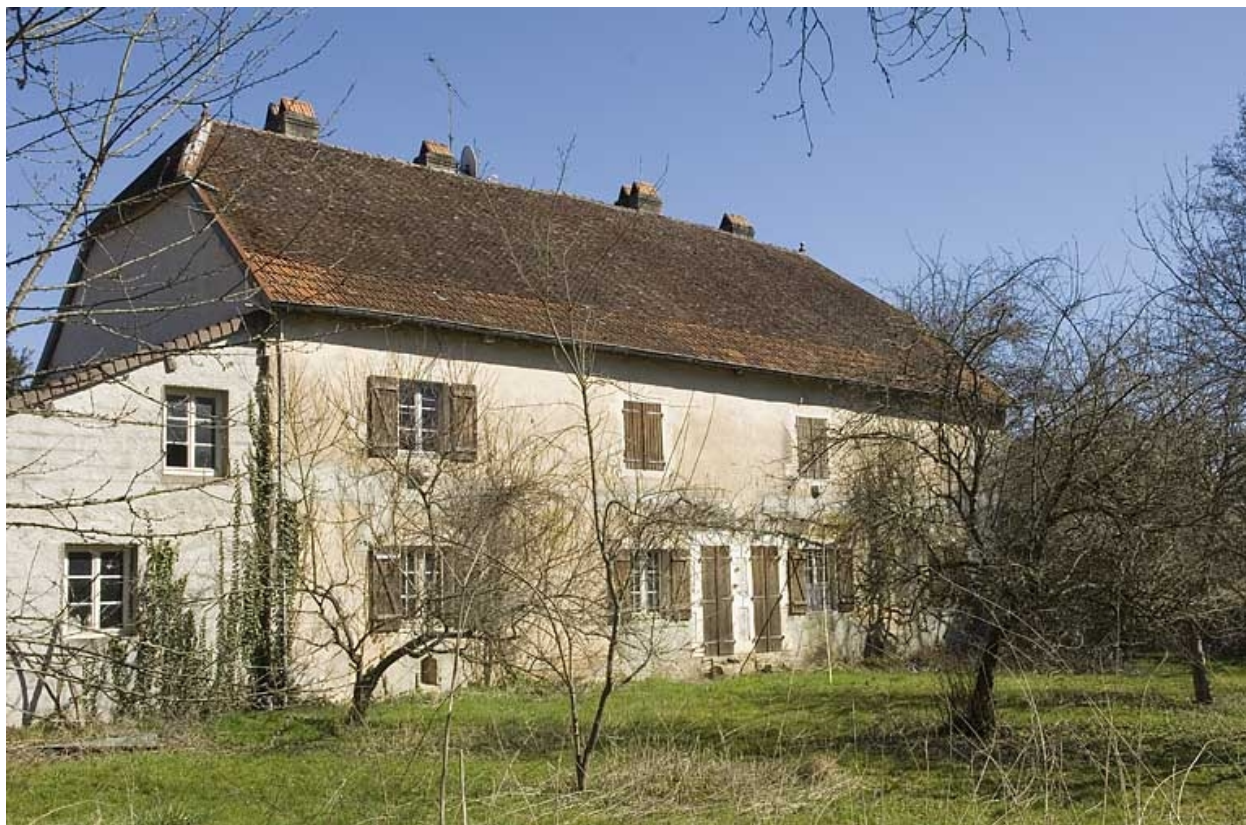
Logement d'ouvriers. Façade postérieure.
