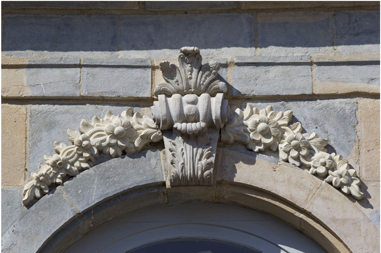
Façade en fond de cour, avant-corps central, fenêtre du premier étage : clé de l'arc, détail du décor feuillagé encadré de deux guirlandes de fleurs.
