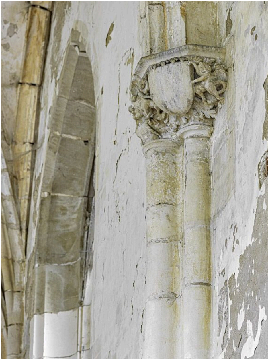
Chapiteau de la nef, entre la 3è et la 4e travée.
