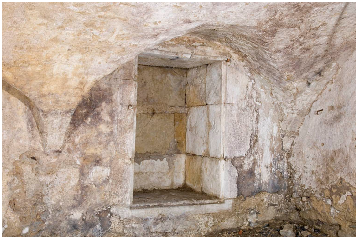
Sous-sol : détail de la niche.
