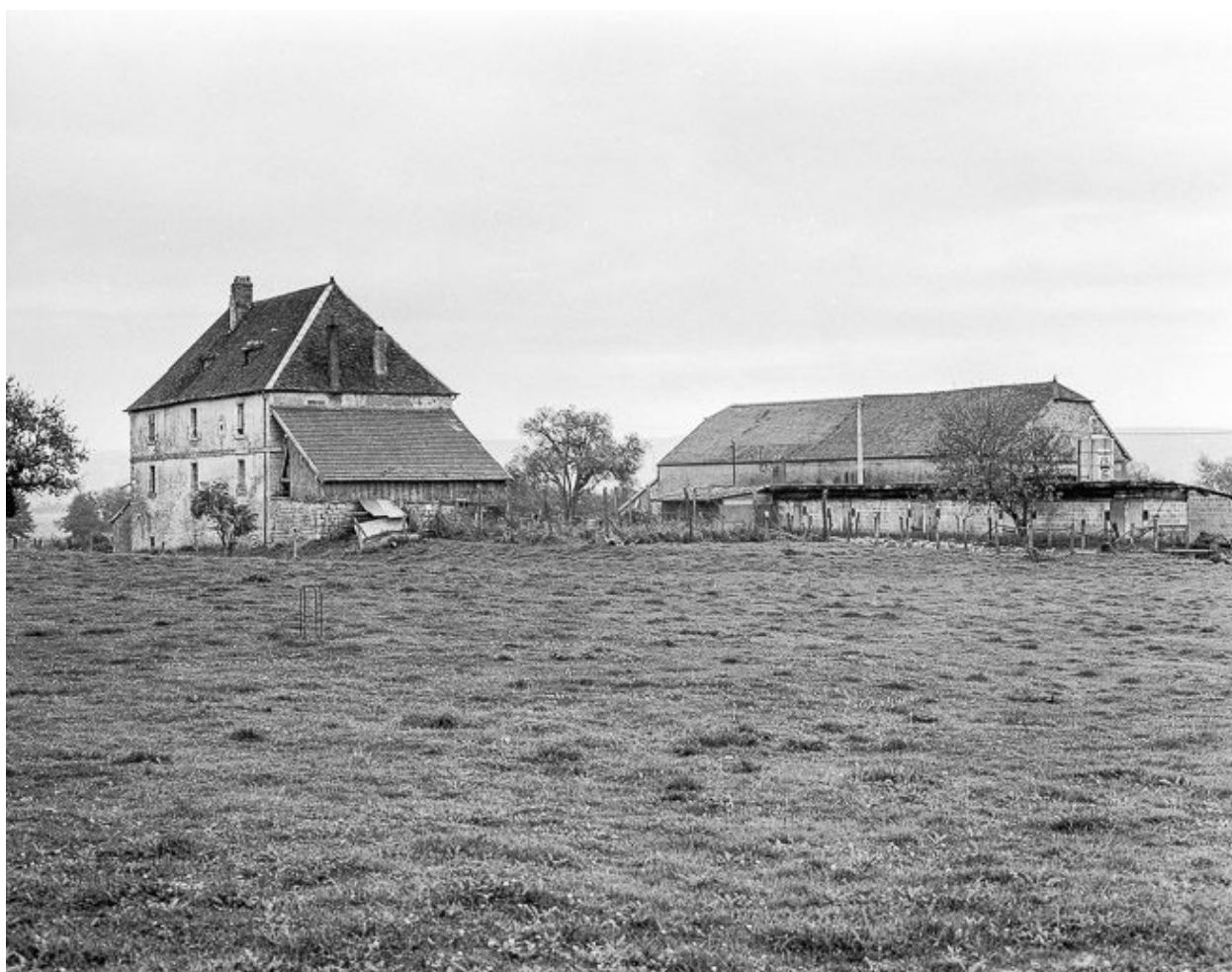
Façades postérieure et latérale droite.
