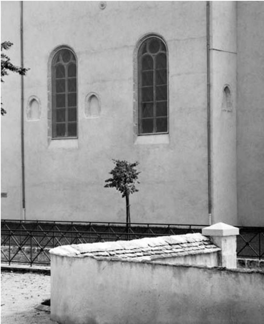
Façade latérale gauche de la chapelle : baies mises à jour lors de la rénovation de 1981-1983.
