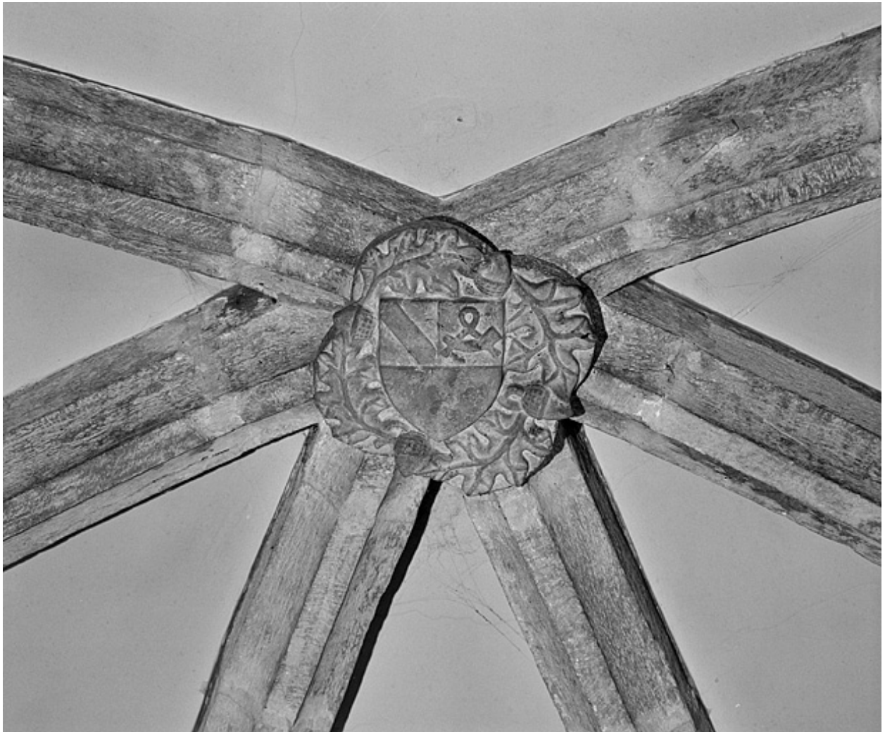
Eglise Saint-Désiré. Clef de voûte de l'abside.
