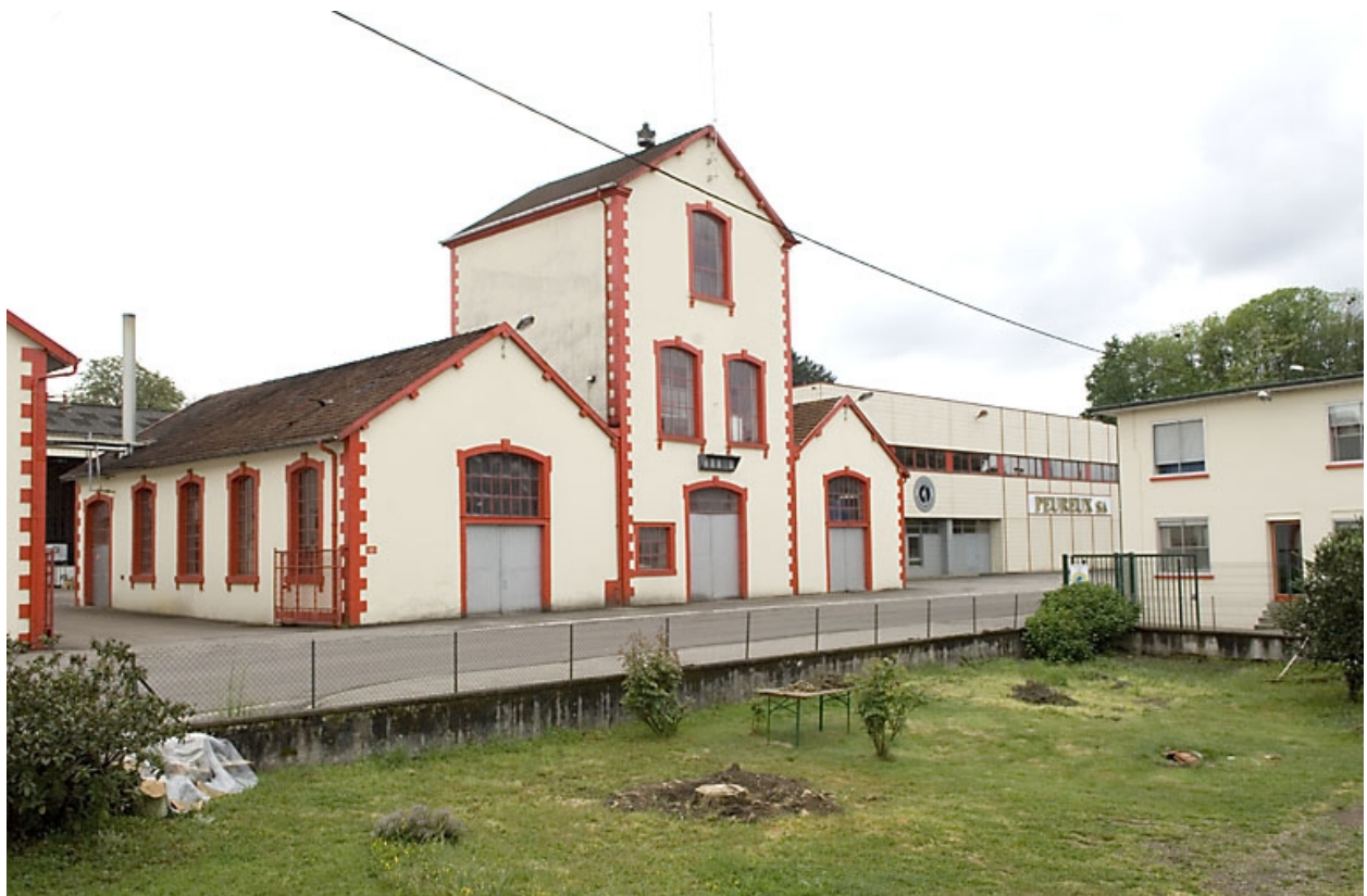
Bâtiments industriels. Vue de trois quarts gauche.
